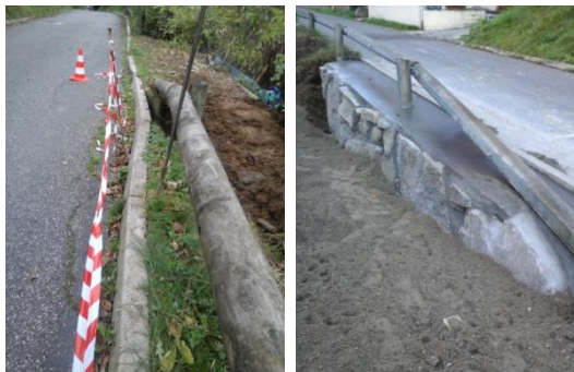
Mur de soutènement rue du Felsenbach
